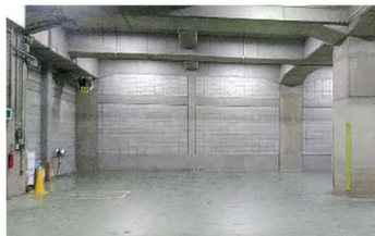
積替ステーション併設倉庫
